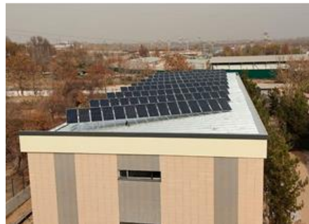
1-расм. “SUN-HIGHTECH” МЧЖ томонидан Д.И.Менделеев номидаги Россия кимё-технология университетининг Тошкент шаҳри филиалида ўрнатилган қуввати 100 кВт бўлган қуёш станцияси
