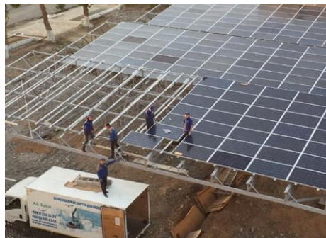
2-расм. “ALL SOLAR” ХК томонидан “SAMARKAND APPAREL” МЧЖ корхонаси эҳтиёжлари учун ўрнатилган ва ишга туширилган қуввати 130 кВт бўлган қуёш электр станцияси
