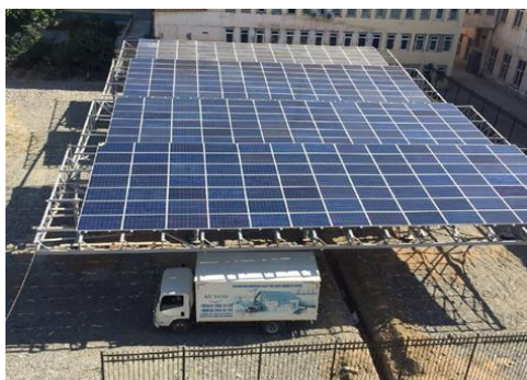
2-расм. “ALL SOLAR” ХК томонидан “SAMARKAND APPAREL” МЧЖ корхонаси эҳтиёжлари учун ўрнатилган ва ишга туширилган қуввати 130 кВт бўлган қуёш электр станцияси
