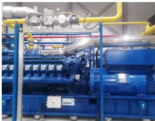
Рис. 2. Газовый двигатель и генератор; на заднем плане — акустические стеновые панели зала (Чиланзар)
