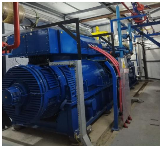
Рис. 3. ГПУ с локальным акустическим кожухом, мини-ТЭЦ Сергели
