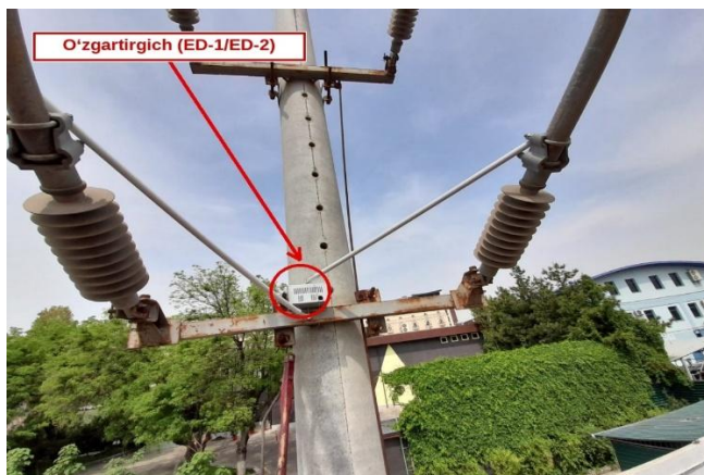
3-rasm. O'zgartirgichning amaldagi kontakt tarmog'i uchastkasida tayanch konsoliga o'rnatilgan holati
