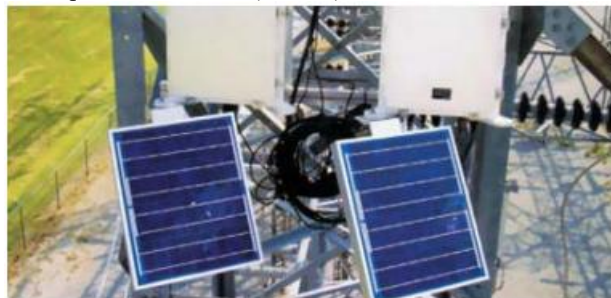
4-rasm. CAT-1 quvvat moduli. CAT-1 o'lchash modulini tayanchda o'rnatilishi.
