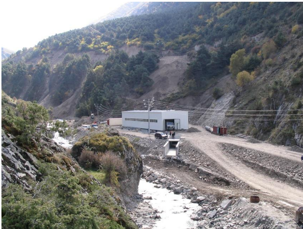
Рис. 5. Общий вид на станционный узел Фаснальской МГЭС.
