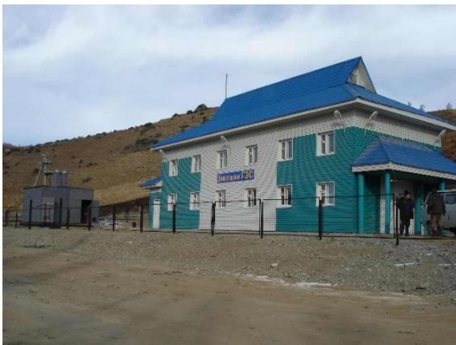
Рис. 4б. МГЭС «Джазатор»: общий вид станционного здания [5]. Fig. 4b. MGES "Jazator": general view of the station building.
