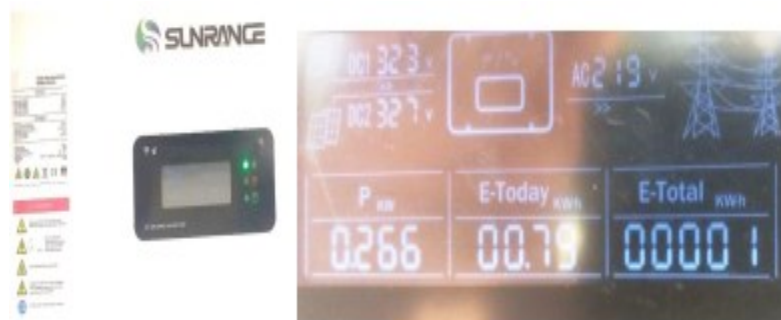
Рис.4. Фото 2-х трекового инвертора и индикации электрических параметров установки. Fig.4. Photo of a 2-tracker inverter and an indication of the electrical parameters of the installation.
