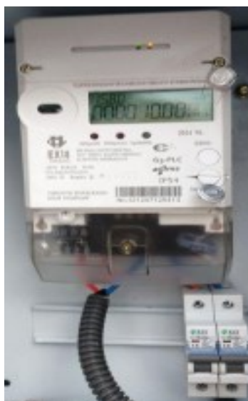
Рис.6. Фото счетчика электроэнергии однофазного марки EX-18. Fig.6. Photo of a single-phase electricity meter of the EX-18 brand.
