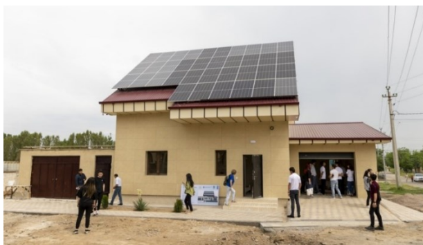
Рис.3. Демонстрационный пилотный дом «Zero House» в Нурафшане, Ташкентской области РУз. [38].
